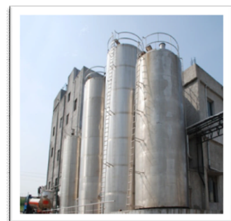
Silo 60 KL under RKVY
